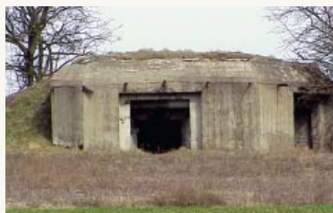
Bunkier Linii Mołotowa, fot. J.S.Wasilewski
