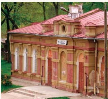
Budynek dworca w Nurcu-Stacji, fot. C. Klimaszewski
